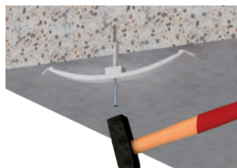
Einschlagen in die Decke
